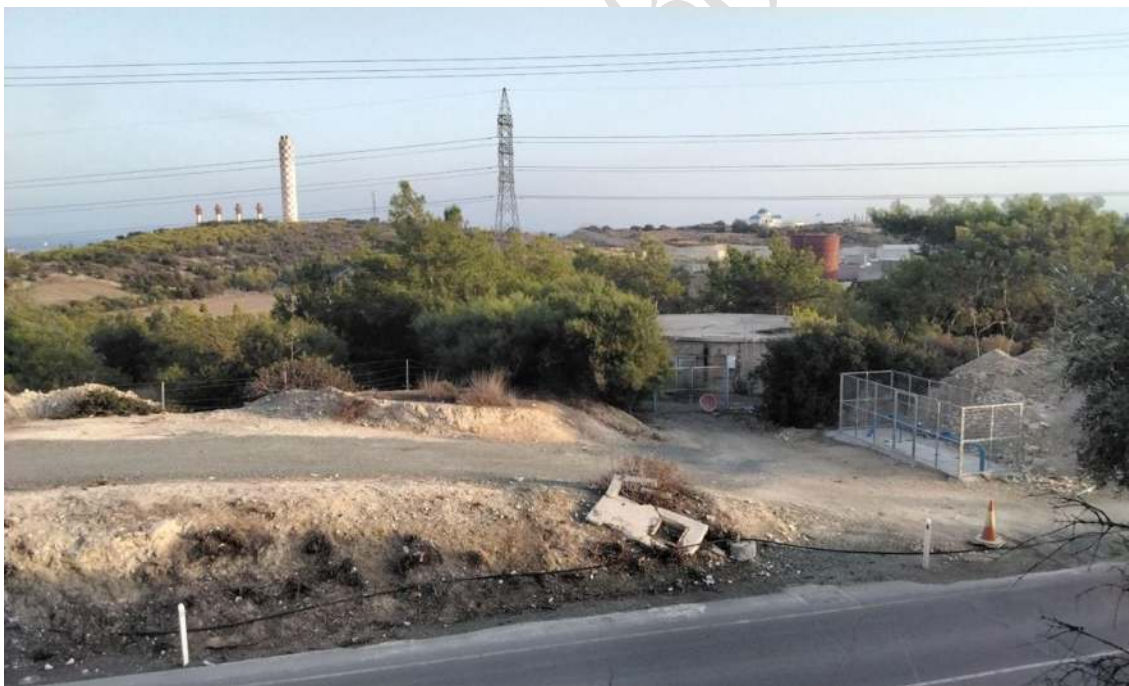
Εικόνα 56: Πυλώνας ΑΗΚ και νεπόζιτο νερού
