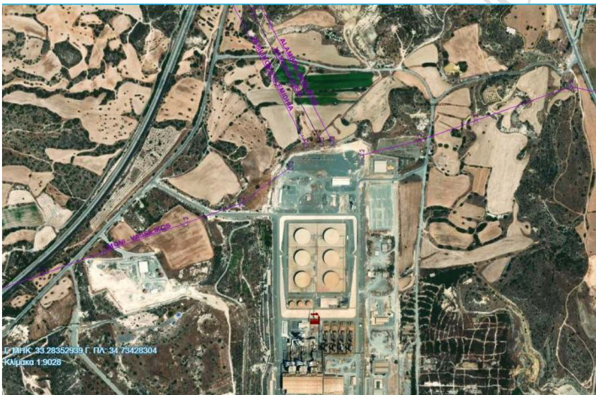
Εικόνα 12: Υφιστάμενο εναέριο δίκτυο μέσης τάσης ΑΗΚ
