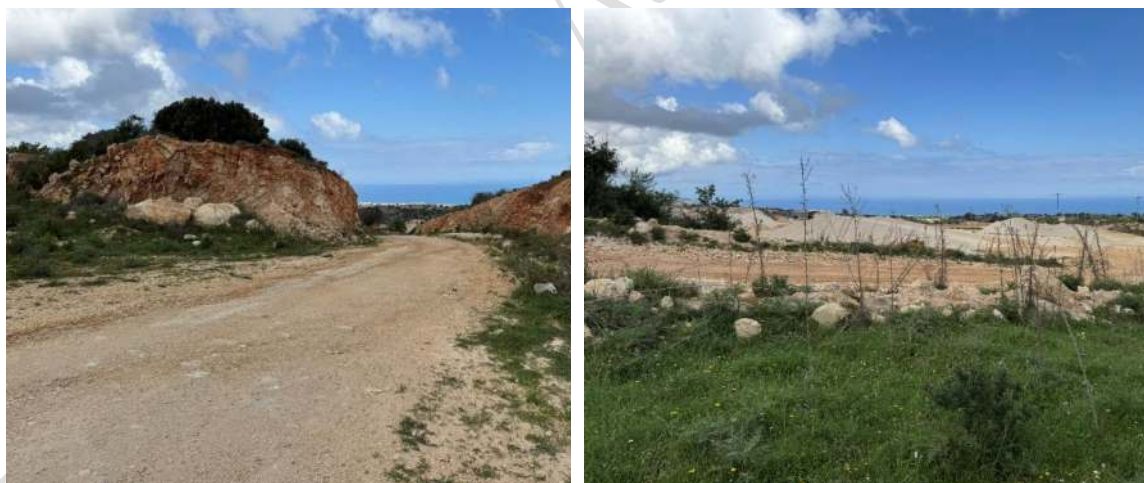
Εικόνα 38: Χωμάτινο οδικό δίκτυο εντός του τεμαχίου 168
